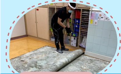
更換地板工程
